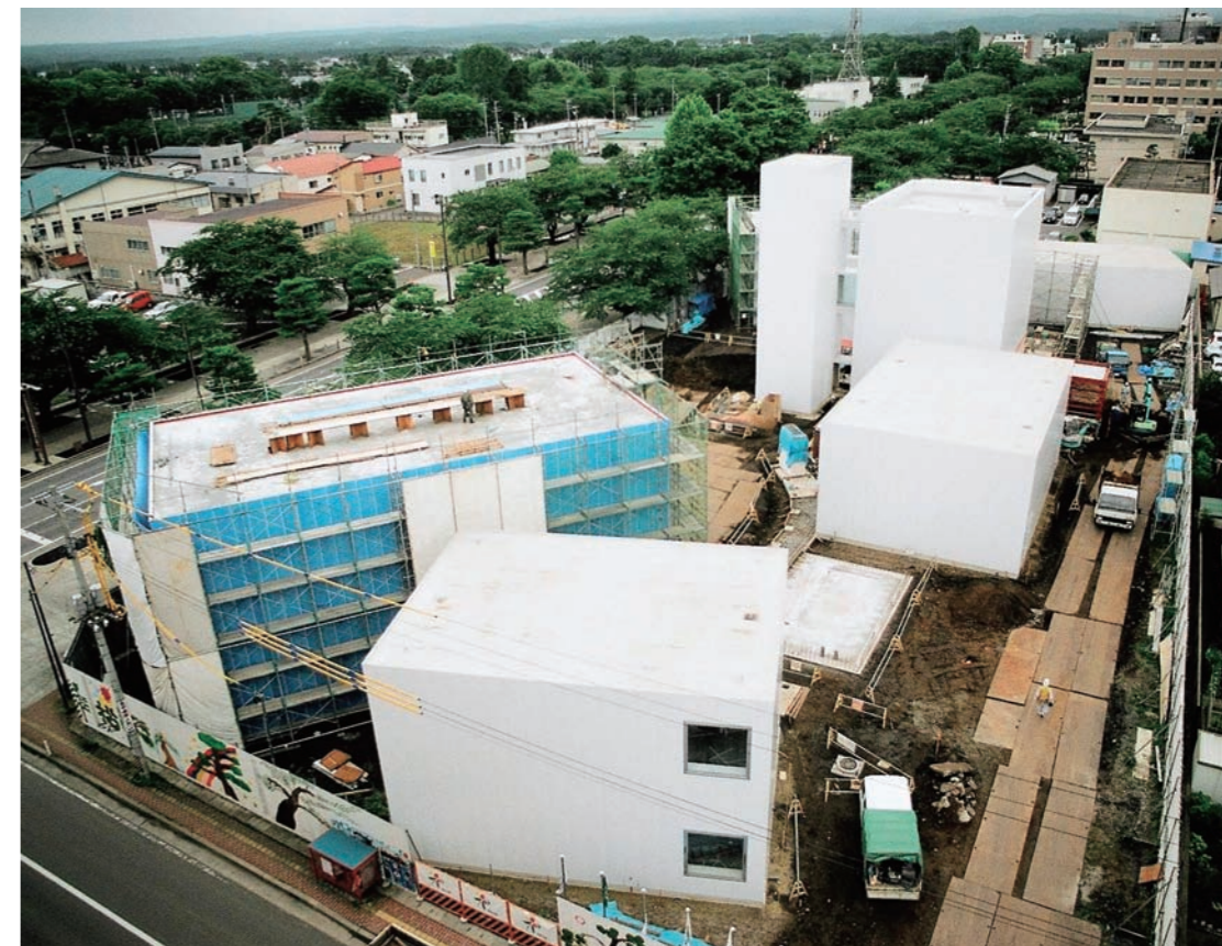
●7月の建築状況（消防署訓練棟から）
