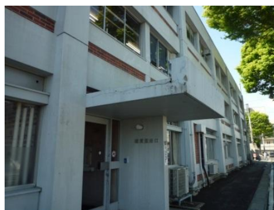
本庁舎本館外観
