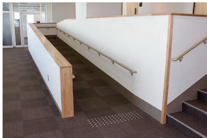
車椅子を使う傍聴者のためスロープを設置
