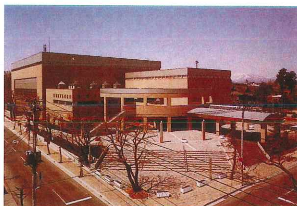
社会体育事業推進拠点施設の総合体育センター
