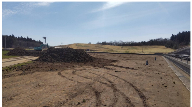
令和8年2月14日 着工
