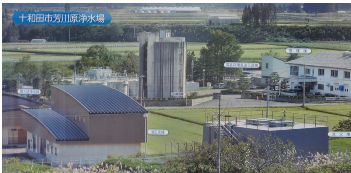
芳川原浄水場
