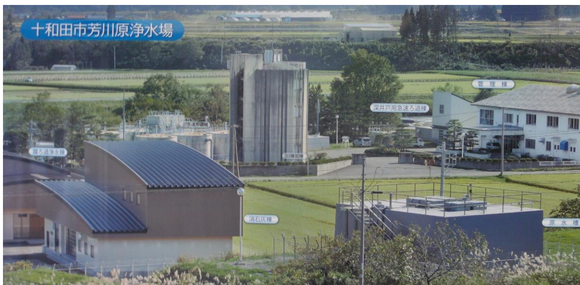
芳川原浄水場
