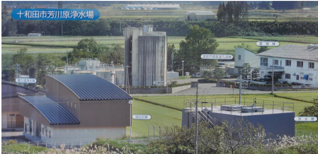
芳川原浄水場
