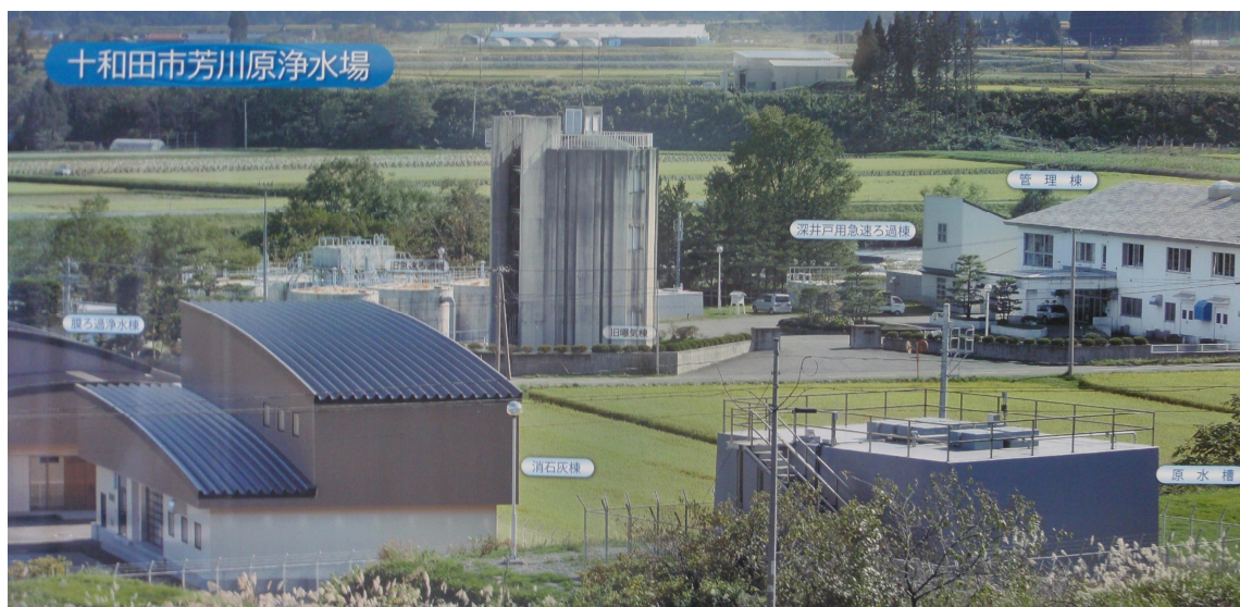
芳川原浄水場
