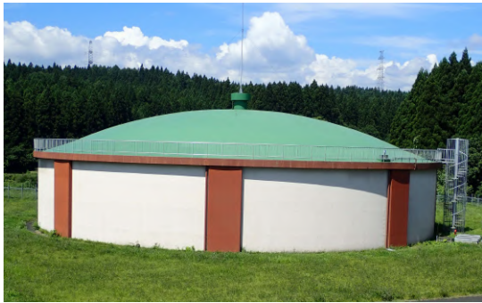
塚ノ下 3号配水池
