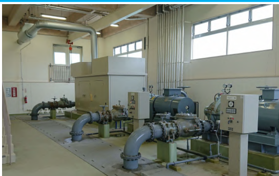
芳川原送水ポンプ設備(2号・3号)
