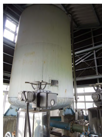
深井戸急速ろ過設備
