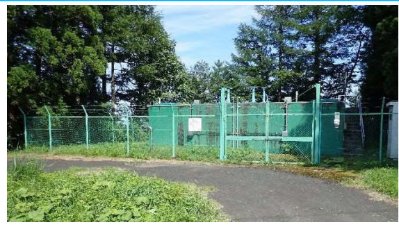
伝法寺配水場
