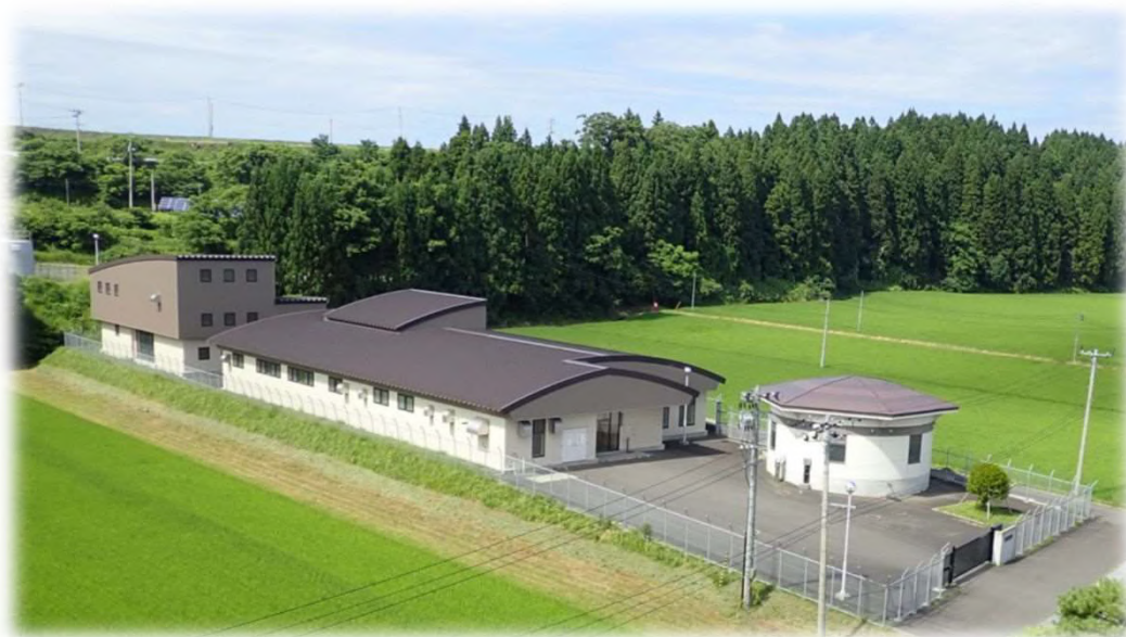
芳川原浄水場 膜ろ過棟
