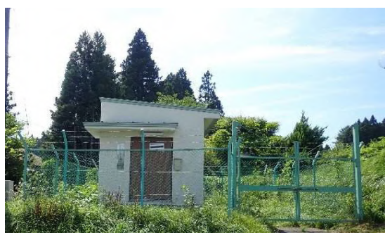
伝法寺地区送水ポンプ場
