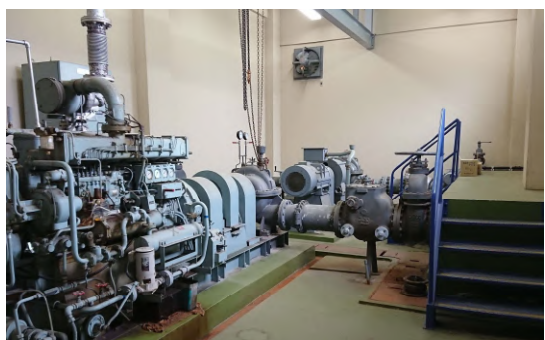
芳川原送水ポンプ設備(1号)
