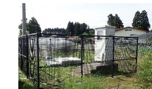
深持増圧ポンプ場
