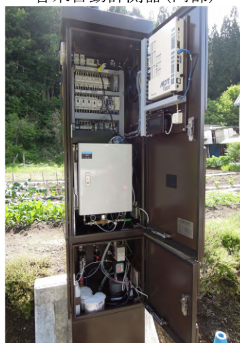
管末自動計測器(内部)
