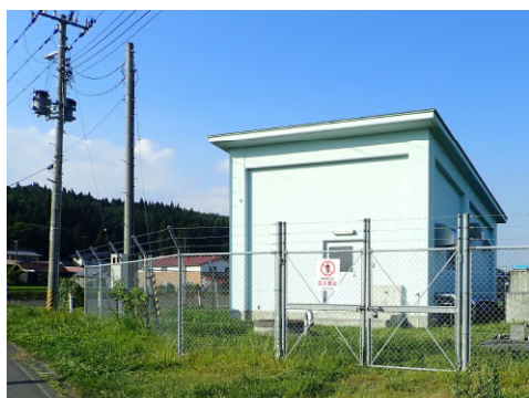
長下取水施設・浄水場
