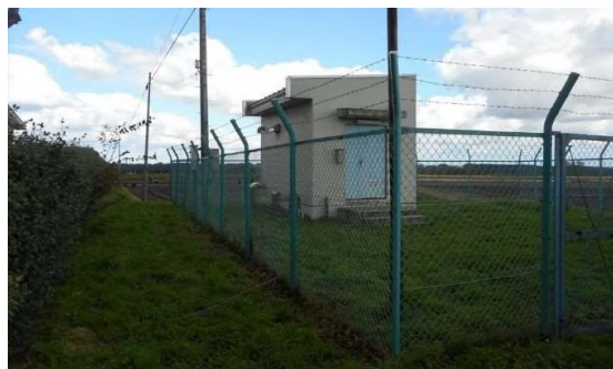
切田地区送水ポンプ場
