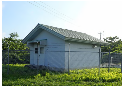
滝沢取水施設・浄水場
