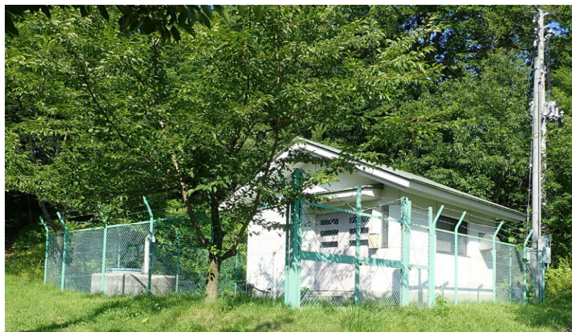
取水施設・浄水場
