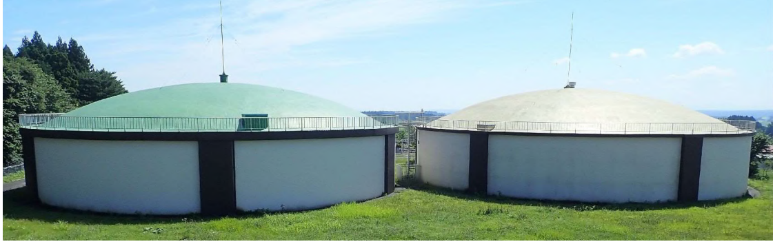
塚ノ下 2号配水池
