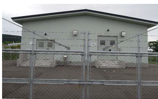
法量送水ポンプ場
