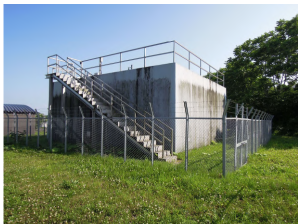
膜ろ過原水槽
