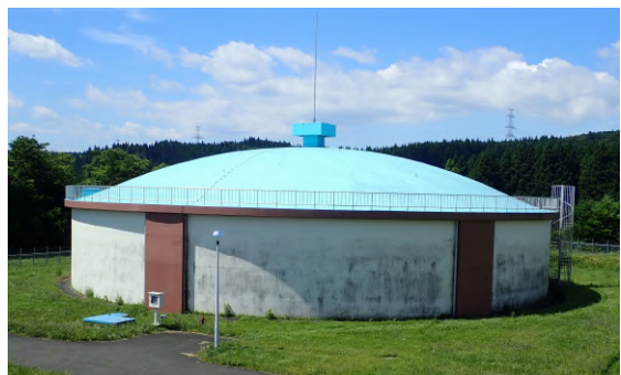
塚ノ下 4号配水池
