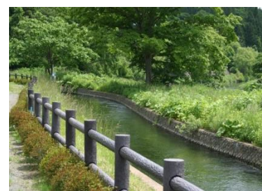
稲生川幹線用水路
