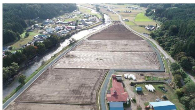
令和5年度区画整備工事実施後 (令和5年10月16日撮影)
