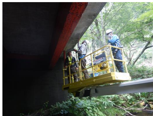
西の沢線1号橋の定期点検の様子
