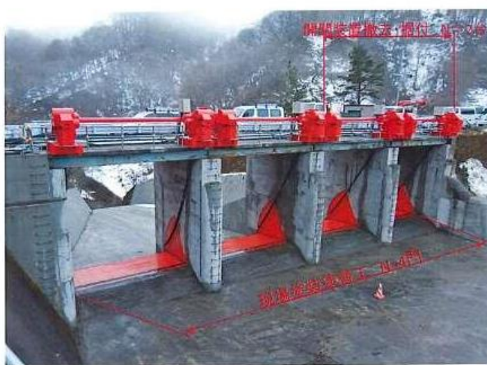
ゲート巻上機更新、ゲート塗装完了状況
