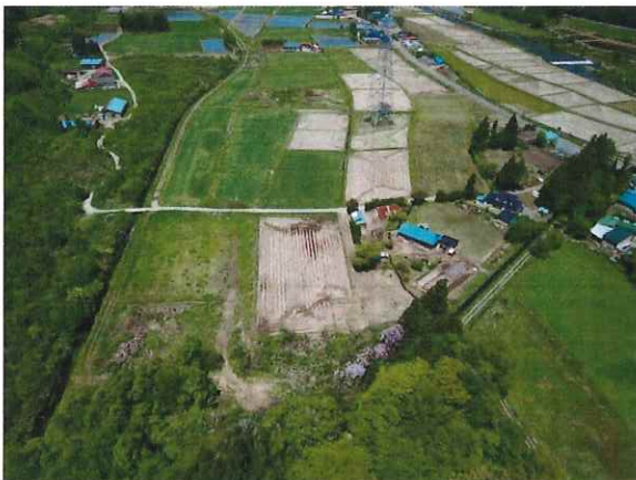
令和3年度区画整備工事実施前 (令和3年5月20日撮影)
