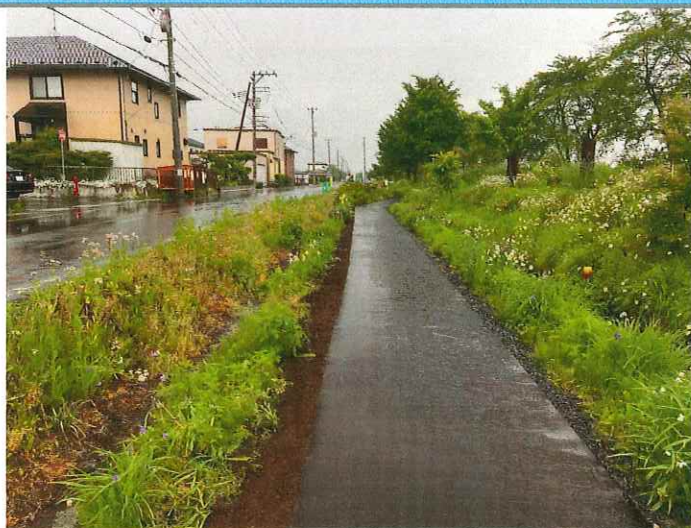
稲生川ふれあい公園補修後の遊歩道
