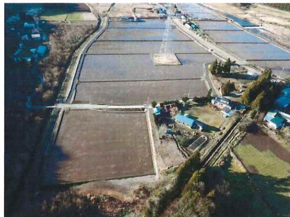
令和3年度区画整備工事実施後 (令和3年12月3日撮影)
