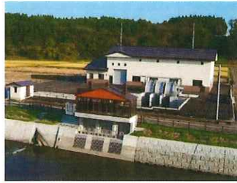
砂土路川揚水機場
