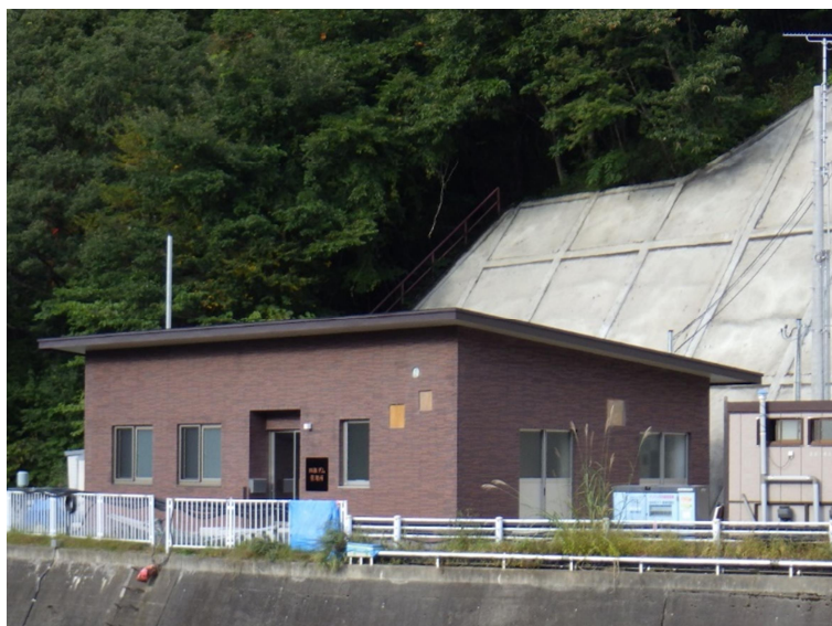
ダム管理棟新築
