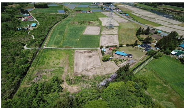
区画整備工事実施前 (令和3年5月20日撮影)
