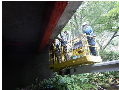
西の沢線1号橋の定期点検の様子
