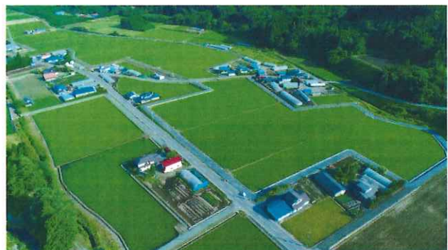
令和4年度区画整備工事実施後 (令和5年6月26日撮影)
