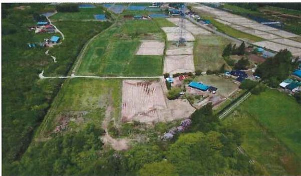
令和3年度区画整備工事実施前 (令和3年5月20日撮影)
