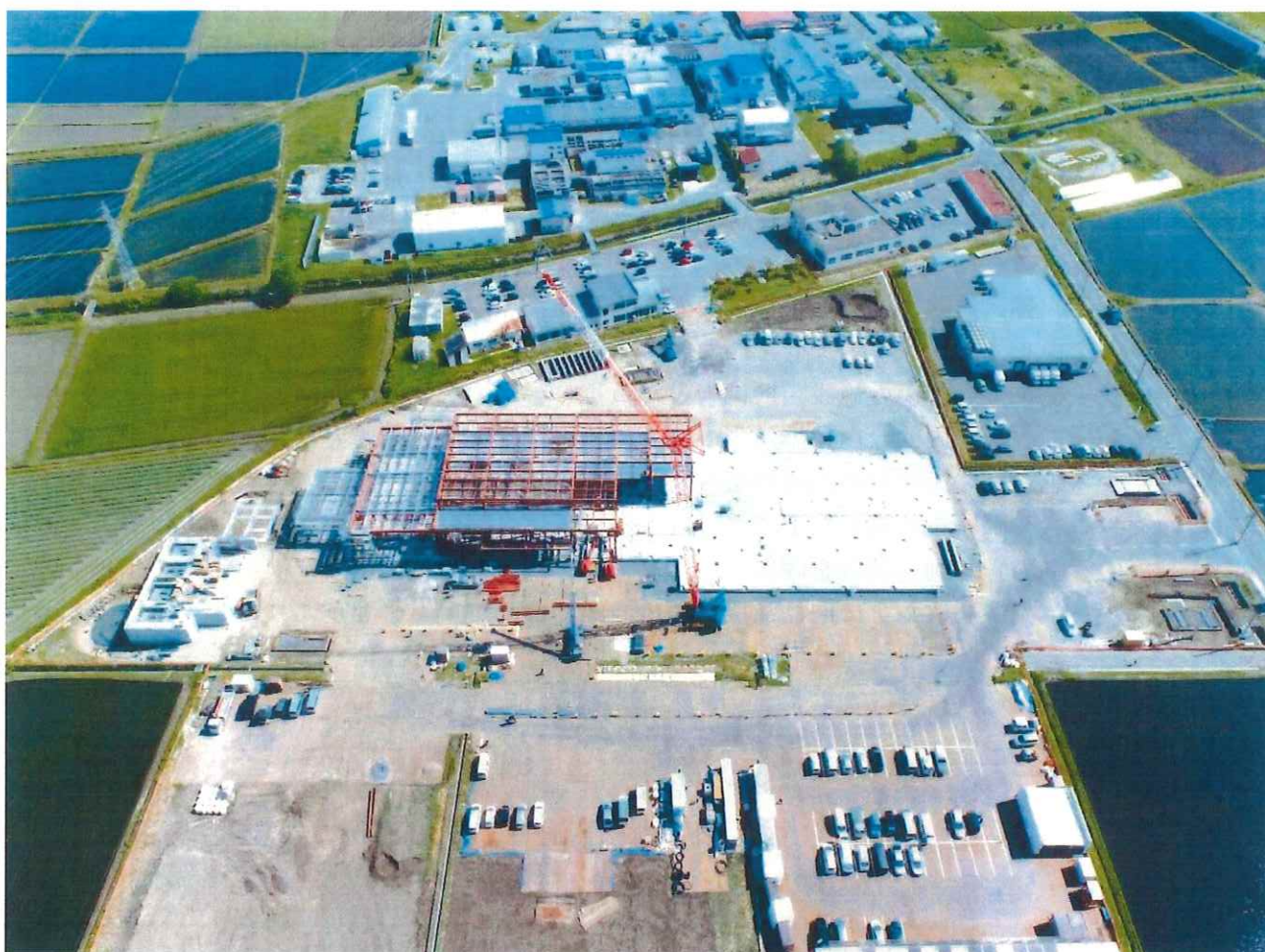
建設中の牛処理加工施設（IH ミートパッカー(株)十和田ミートプラント）
