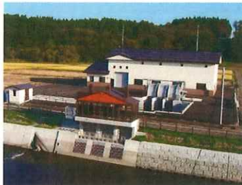
砂土路川揚水機場
