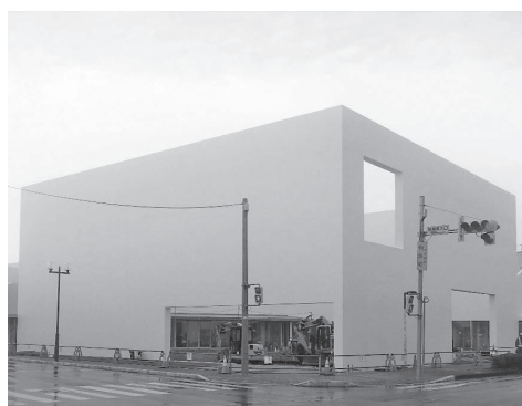
建設中の地域交流センター
