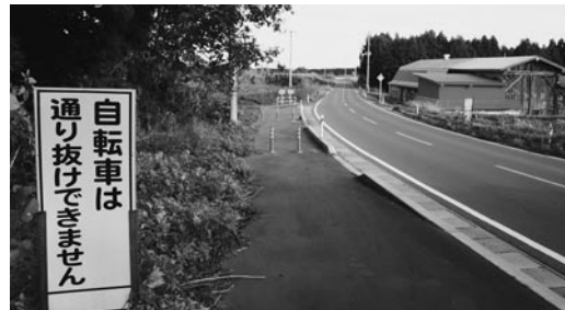
高森山総合運動公園南側の市道
