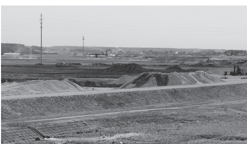
メガソーラー建設が進む下水処理場隣地
