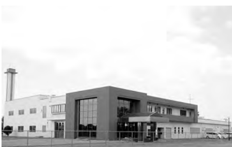
老朽化が進む六戸衛生センター
