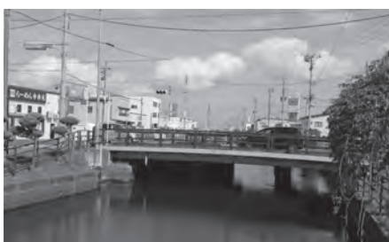
補修を重ね、設置後69年が経過した稲生橋
