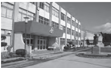
統合された新校舎が建設される大深内中学校
