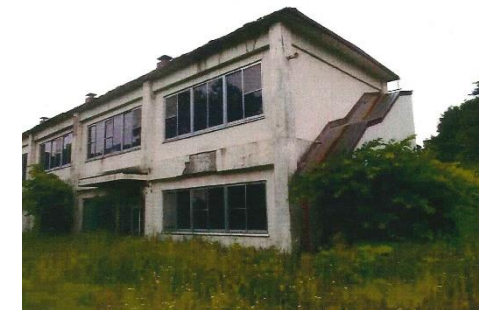
旧自然の家 現況
