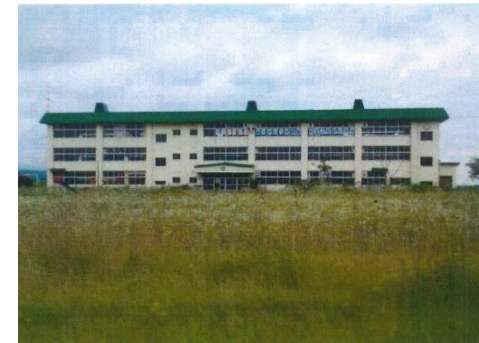
旧上切田小学校 現況
