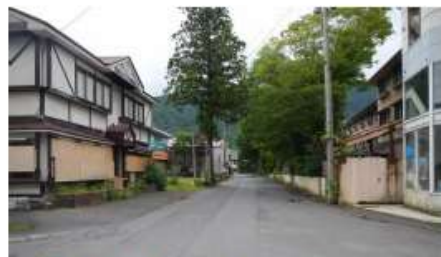
■ 利用拠点の廃屋等（休屋休平地区）
