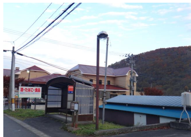
老朽化した街灯(現状)
