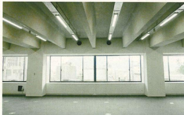
上部床にST床板を採用した執務室事例（短手方向）
