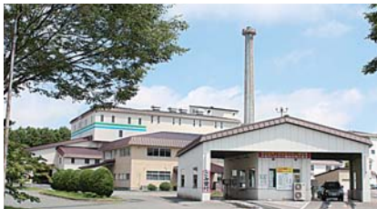
▲市内伝法寺地区にあるごみ処理施設。毎日、多くのごみが処理されています。
