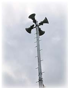
下切田屯所付近に設置の屋外拡声子局
