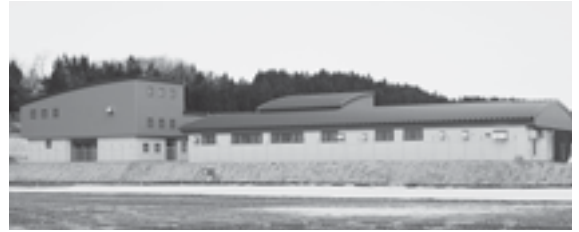
芳川原浄水場に完成した高度浄水設備
