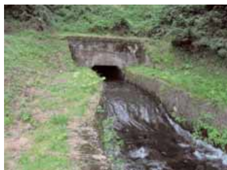
③ 天狗山トンネル出口
