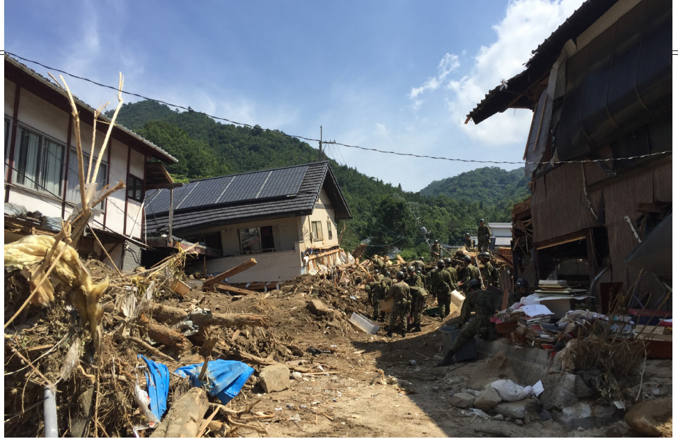
豪雨災害の被災状況（天応地区）
