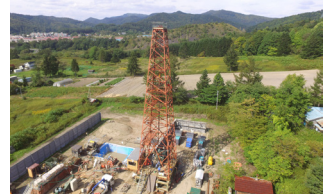
CBM 試掘・生産テスト現場
