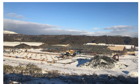
2021年4月の稼働に向けて建設中の研修牧場
