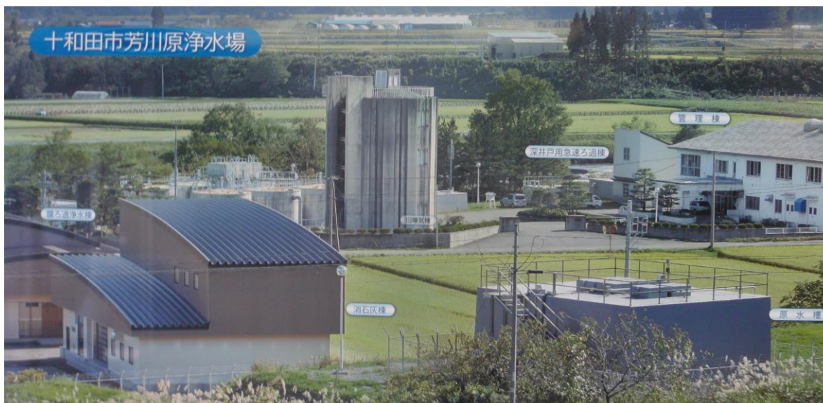
芳川原浄水場
