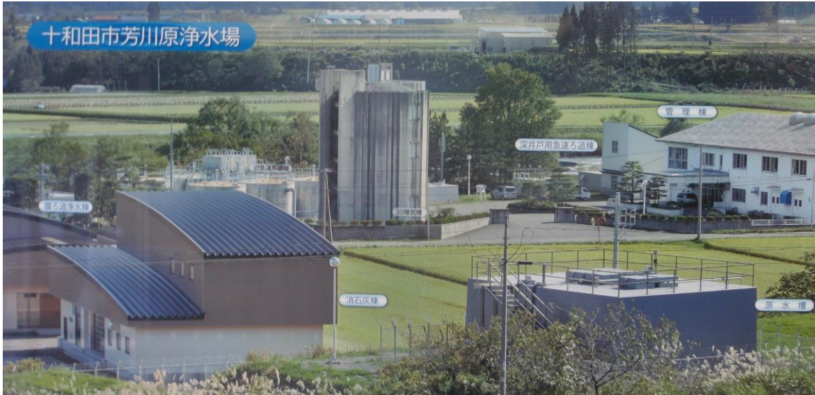
芳川原浄水場
