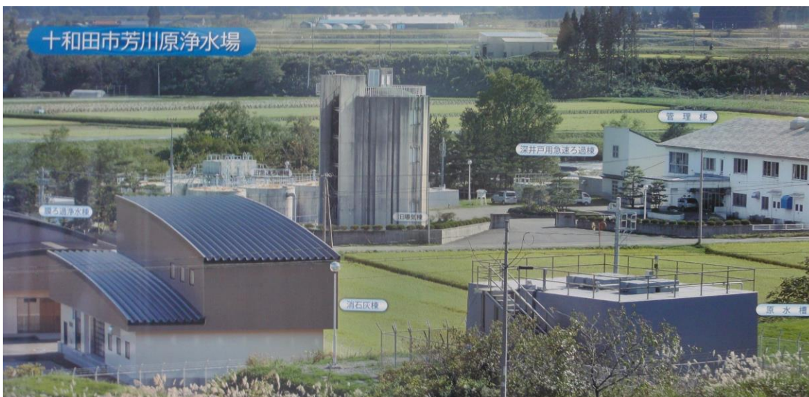
芳川原浄水場
