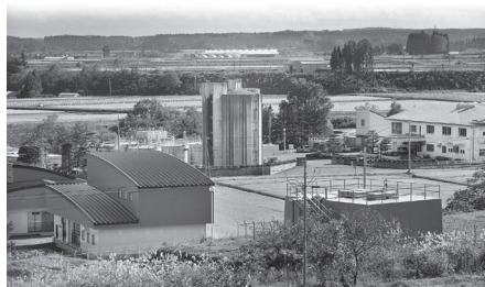
安全な水の安定供給のために
