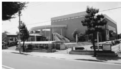
避難所に指定されている総合体育センター
