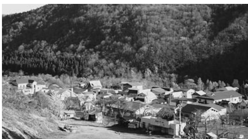
消火栓の整備が望まれる十和田湖温泉郷
