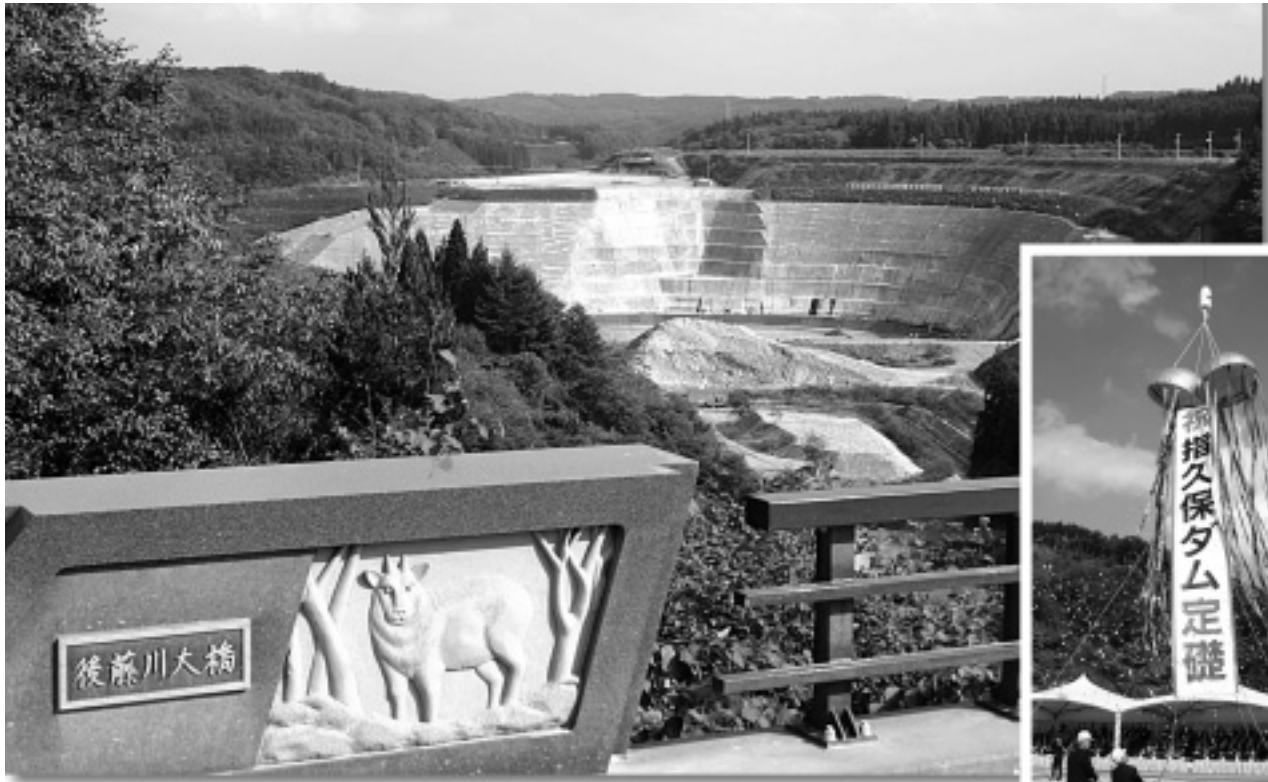
建設中の指久保ダム
