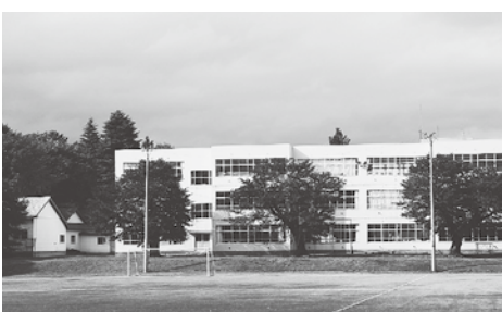
改修が必要な三本木中学校舎
