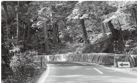
8月に発生した土砂崩れ
