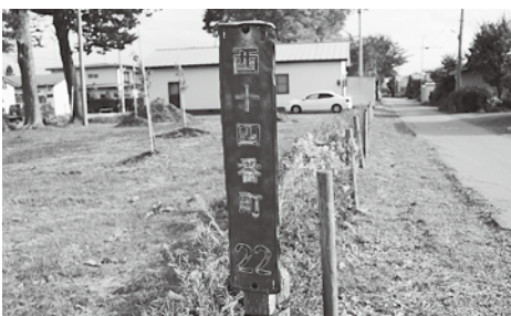
経年劣化している街区表示板
