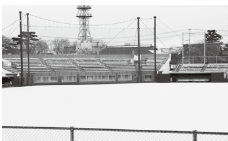
整備が望まれる市営野球場
