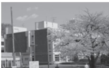
建てかえが必要な市庁舎本館
