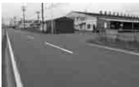
道幅が狭い卸売市場前の道路
