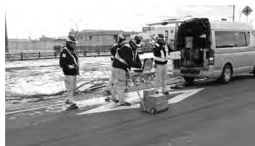
路面下空洞調査の様子
