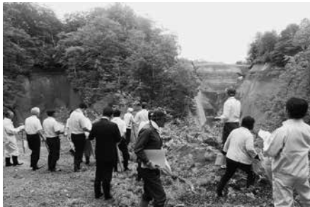
中央の右奥が施工部分
