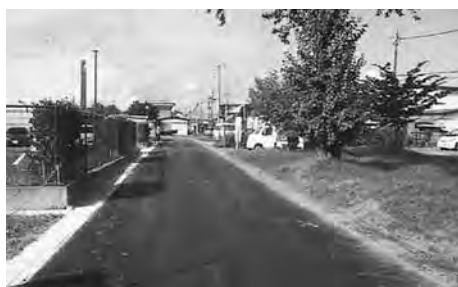
今年度整備した北小付近の市道
