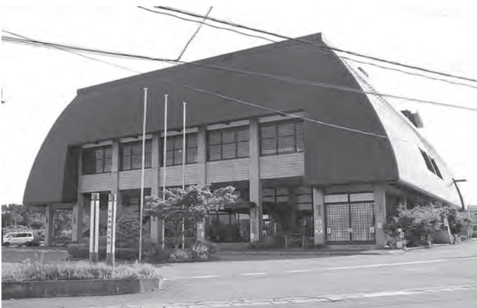
解体予定の旧十和田湖公民館
