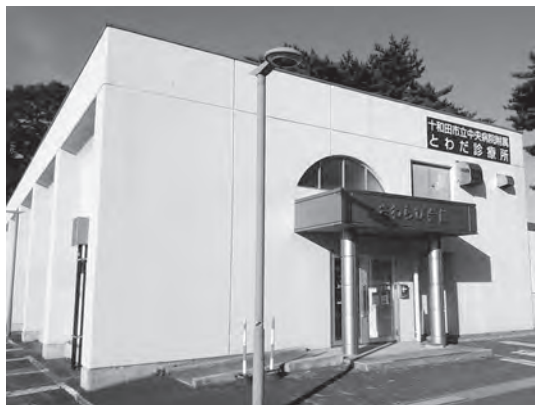
診療所が設置される「さわらび会館」
