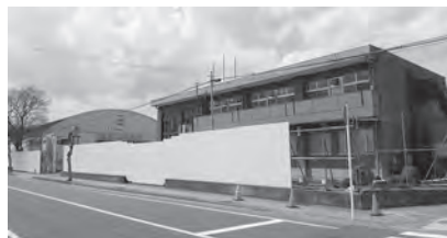
解体関連施設
