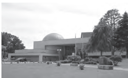
改修工事を終えた市民文化センター
