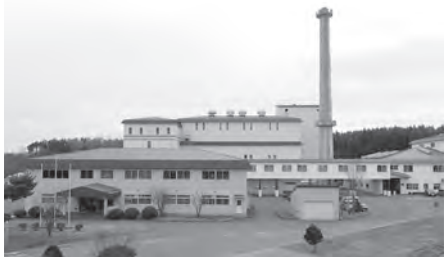
処理能力と老朽化が懸念されるごみ焼却施設
