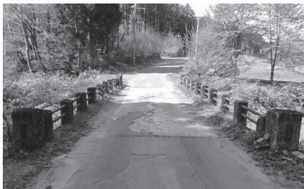
架け替え工事が進められている色内橋
